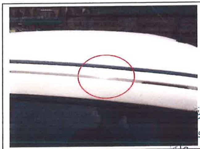
Fot.21. Uszkodzona rama dachu P
